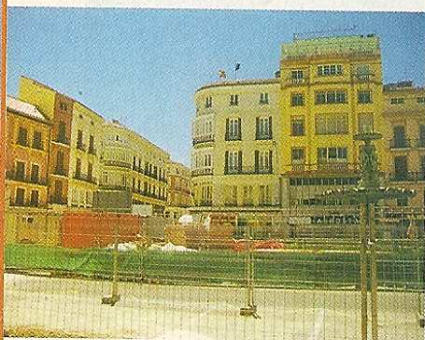
Vistas actuales de las obras llevadas a cabo en la calle Larios y la Plaza de la Constitución.
